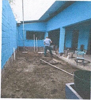
Foto 1: TERMINANDO FOSA SEPTICA Y APELMASANDO EL AREA PARA COLOCARLE TORTA DE CEMENTO
