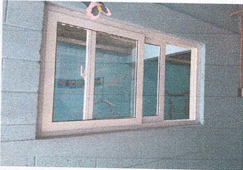
Foto 3: COLOCACIÓN DE VENTANAS.
